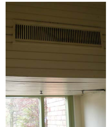
Fläktutrymmet vid entrépartiet målas i samma kulör som tak men med halvblank lackfärg.
