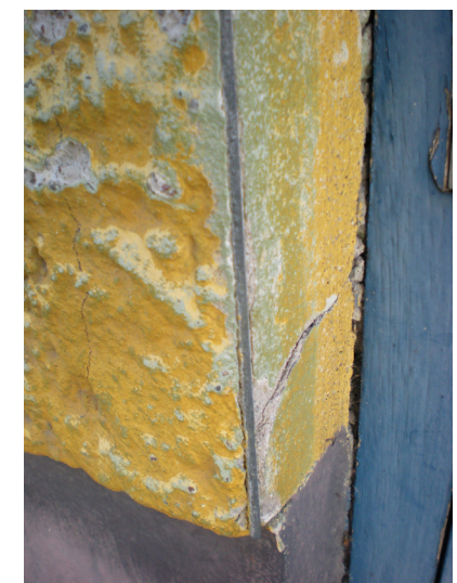
Husets hörn etc verkar vara anpassade till den grova putsen
